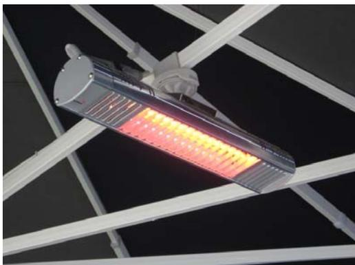
Prima di accendere l'emittente di calore, ruotarla in posizione orizzontale, altrimenti si riduce la durata di vita degli elementi riscaldanti.
