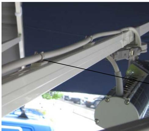
Kabelhalter so an den Schirmstreben anbringen, dass in geöffnetem Zustand das Kabel sauber geführt ist. Die Kabelhalter sind so konstruiert, dass das Kabel bei Zugbelastung aus den Haltern gezogen wird, was beim Schliessen des Schirmes eintreffen kann.
